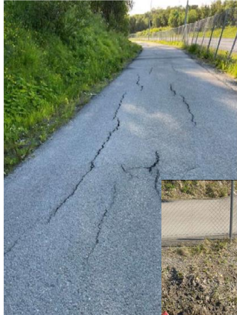
G-/S veg på Tverrforbindelsen (Foto: SVV, Utbygging)
