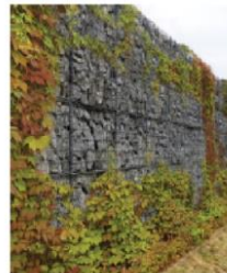
Gabionmur med villin
