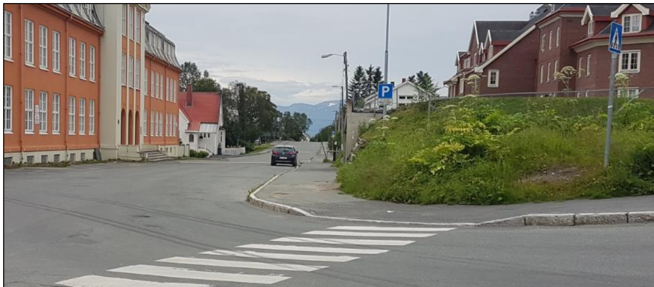
Figur 16 – Eksempel på nedsenket kantstein
