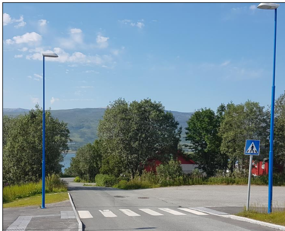
Figur 15 – Eksempel på gangfelt med intensivbelysning
