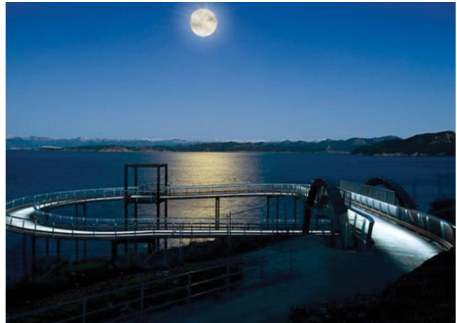
GS-rekkverk på bru med integrert belysning. Foto:
