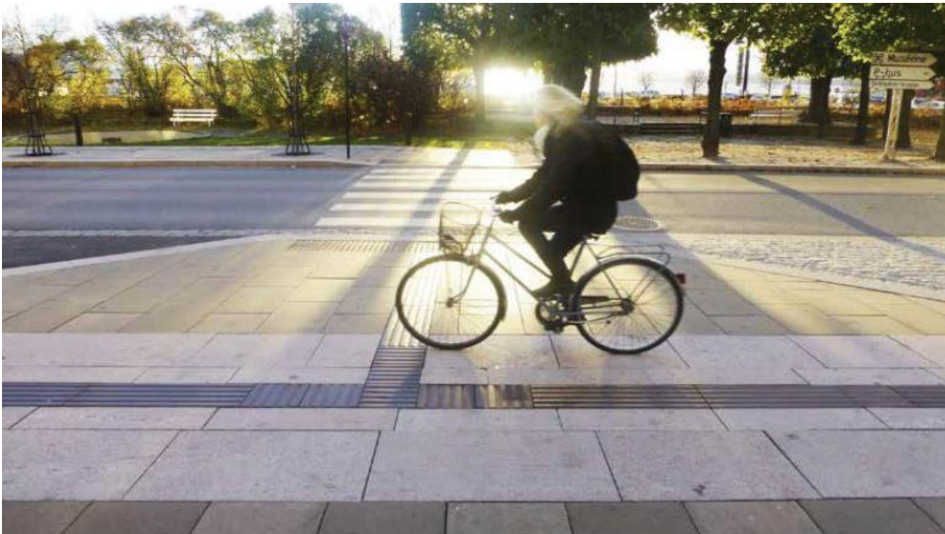
Overgang med kunstige ledelinjer, Strandgata Hamar. Foto Statens vegvesen
