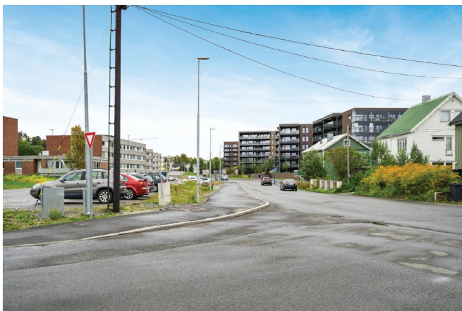
Strandvegen hvor det blant annet skal etableres sykkelveg med fortau og bedre holdeplasser. BILDE BYTTES UT FRA EGNET STED
