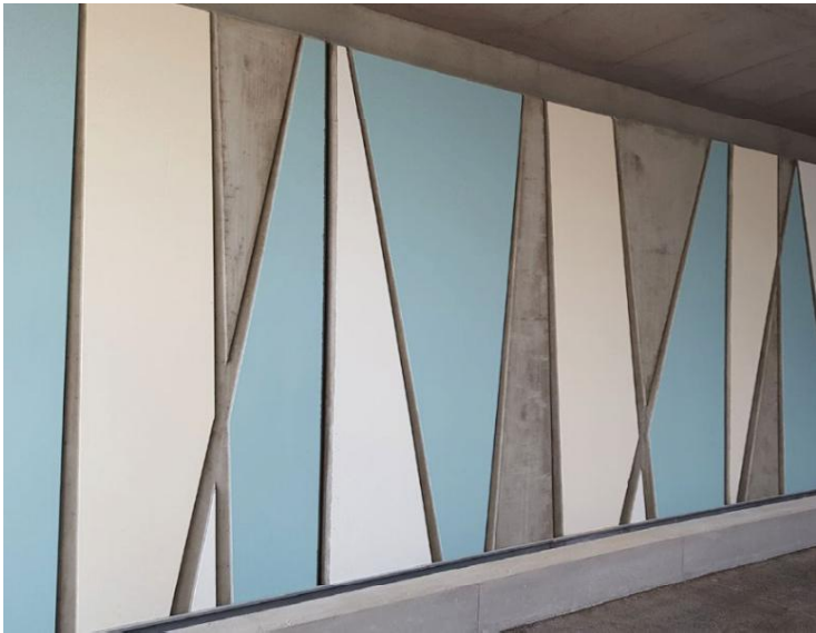
Bilde: Betongvegg i undergang med både relieff i betongen og malte flater. _ Kreditering
