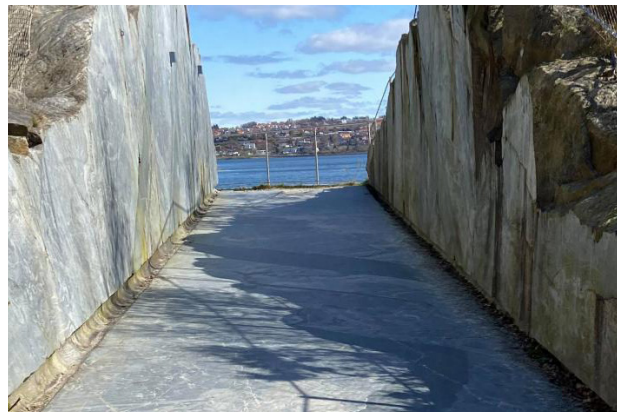
↑ Vaiersaget skjæring. Denne typen overflatebehandling kan gjøres på egnede bergarter, og fremtrer som et spennende arkitektonisk element.
