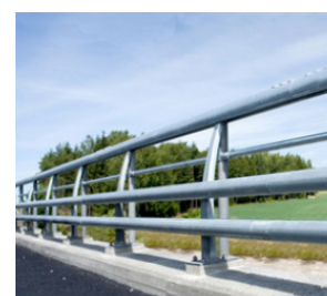
↑ Eksempel på rørrekkverk for veg (til venstre) og brurekkverk (til høyre).
