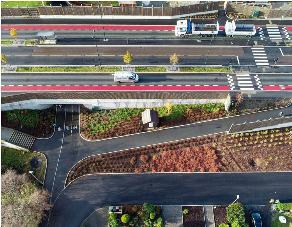
← Terrengforming med rampe ned til gang-/sykkelkulvert under kjøreveg med sykkelanlegg. Store vegetasjonsfelter i skrånende sidearealer, samt grøntrabatter mellom kjørefeltene i veganlegget.
