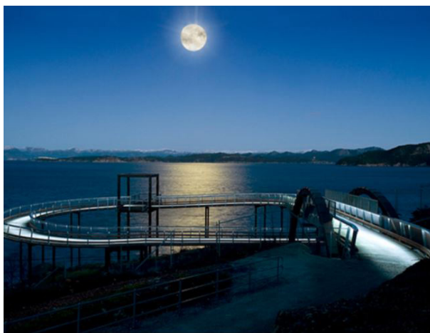
↑ GS-rekkverk på bru med integrert belysning.
