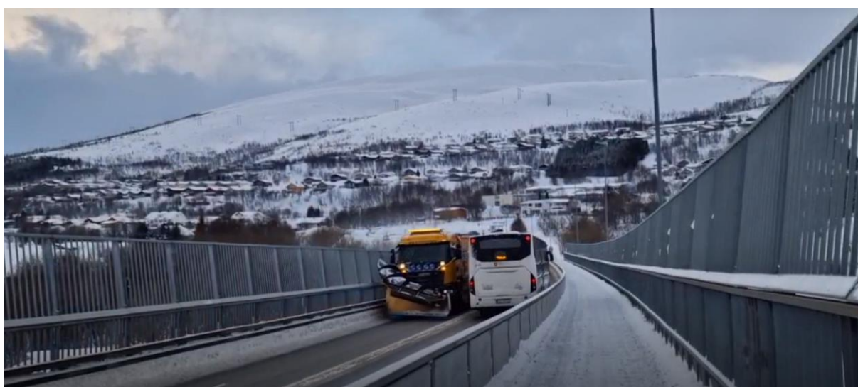
Figur 6-7 Sandnessundbrua fredag 24. mars 2023 ca. kl.17. (befaring AV)
