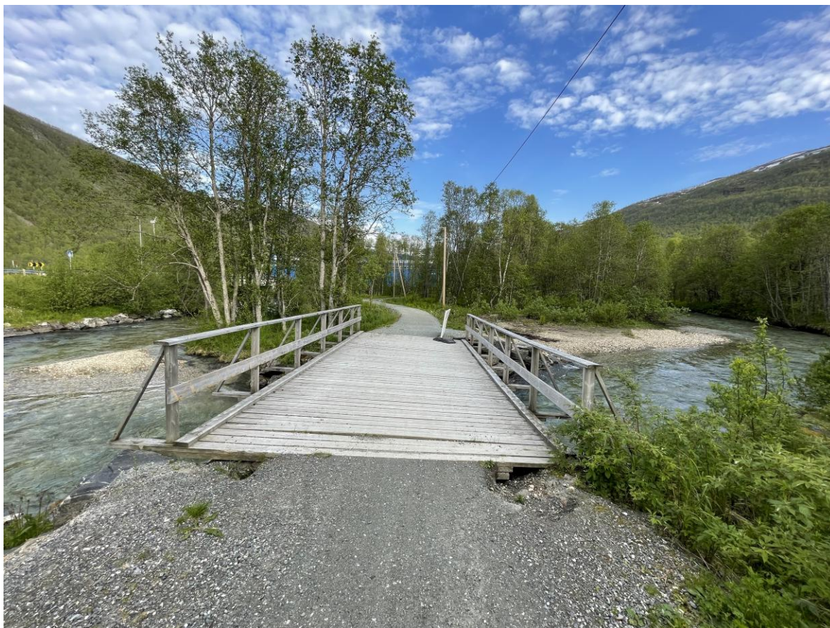
Figur 1: Turvegen og brua ved Tønna. Turvegstreknings mellom Tønna og Pølsesvevet er rustet opp i 2024, mens brua er sliten og noe vindskeiv, med behov for utskifting for å bevare snarvegen de kommende årene.
