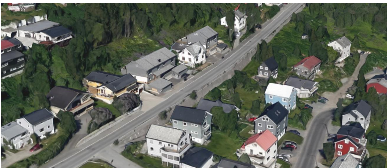
Eksisterende mur på undersiden av Dramsvegen
